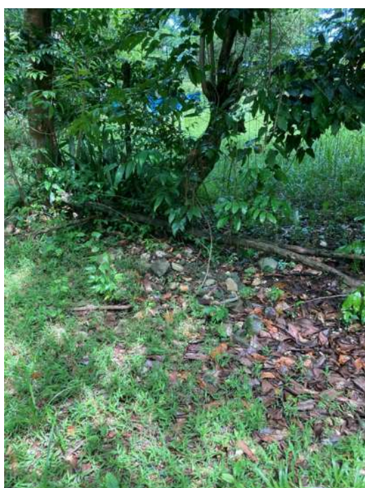
Photographie 5 : Déchets de démolition
