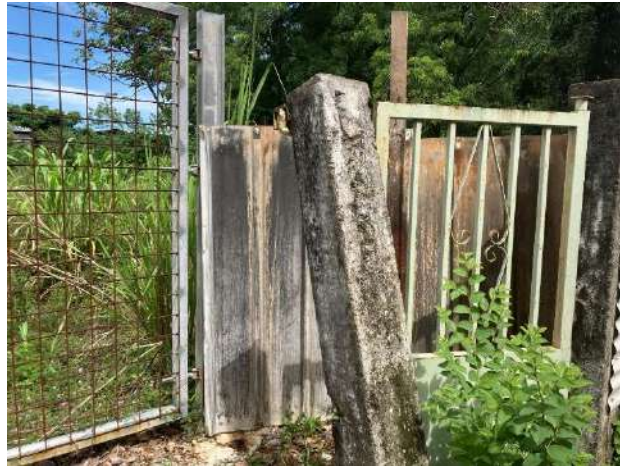
Photographie 1 : Accès au site depuis la rue Michel Lohier
